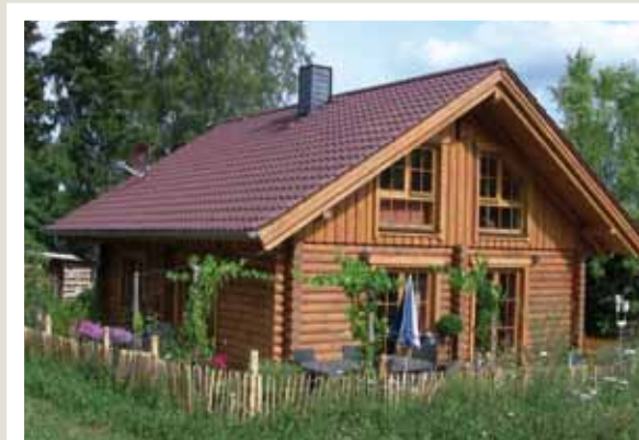
Variante mit Rundbalken ø 210 mm, OG: Holzständerbau
